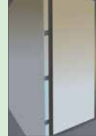
Paso 5 Colocación del tablero por el otro costado
