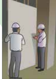
Paso 3 Colocación del tablero por un costado
